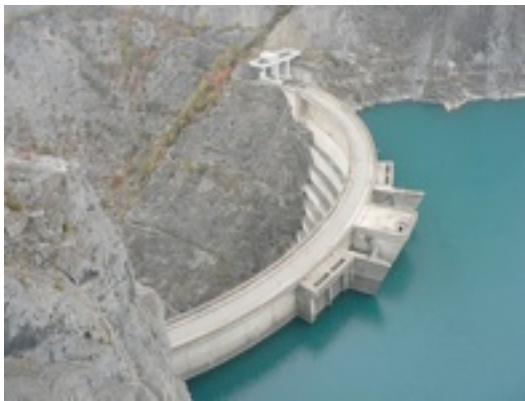
Le barrage de Monteynard (Isère, France), construit en 1962, a créé une retenue d'eau de 650 hectares et alimente une centrale de production de courant hydro-électrique. Photo D. Monniaux/Wikimedia.
