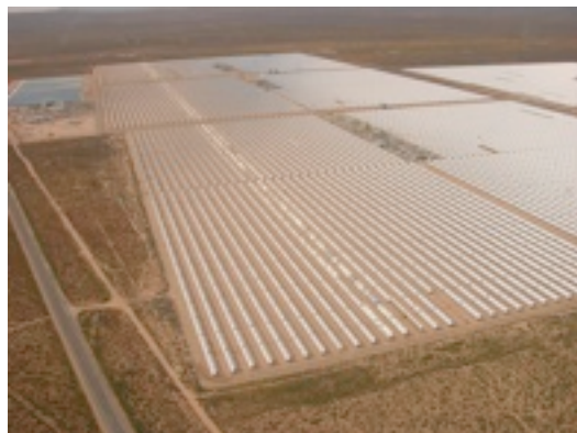
Une partie de la plus grande centrale solaire au monde, installée dans le désert de Mojave, en Californie. L'ensemble de la centrale couvre 6,5 km 2 et produit 350 MW d'énergie électrique. Les zones désertiques sont idéales pour capter l'énergie solaire, qui reste ensuite à transporter et surtout à utiliser immédiatement. Photo A. Radecki/Wikimedia.
