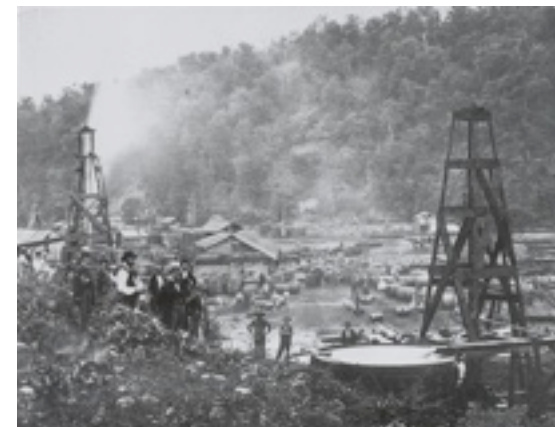
Un des premiers champs de pétrole exploités en Pennsylvanie, vers 1862. Deux puits sont visibles. A l'origine, ces tours de forage, les derricks, étaient utilisés pour rechercher le sel. A cette époque, le pétrole extrait était transporté dans des tonneaux, ce qui explique que l'unité de mesure de la quantité de pétrole soit, encore aujourd'hui, le baril (équivalent à 159 L).
