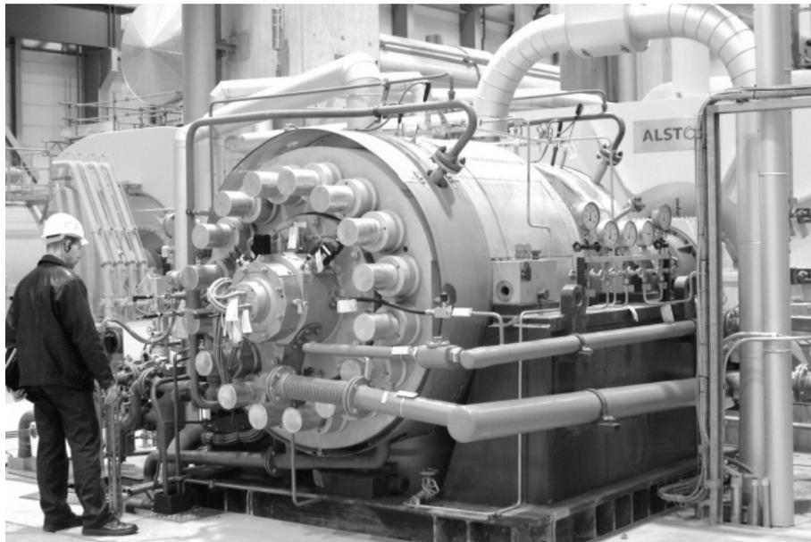
FIGURE 9.2 – Photo d’une pompe du fabricant KSB menant  $2\,500\text{ t h}^{-1}$  d’eau à 350 bar dans une centrale à vapeur.
